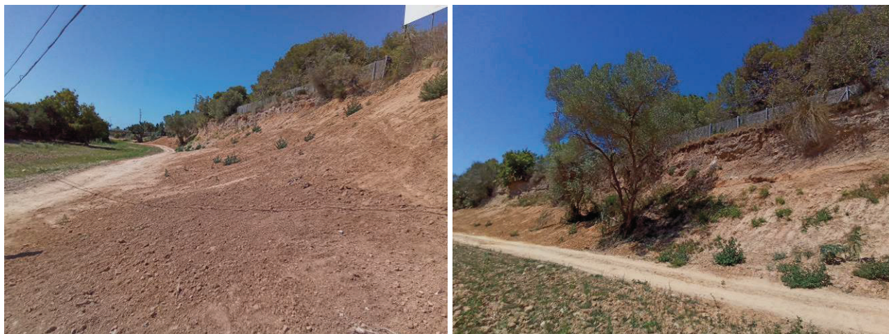
Imatges del talussos del marge dret
