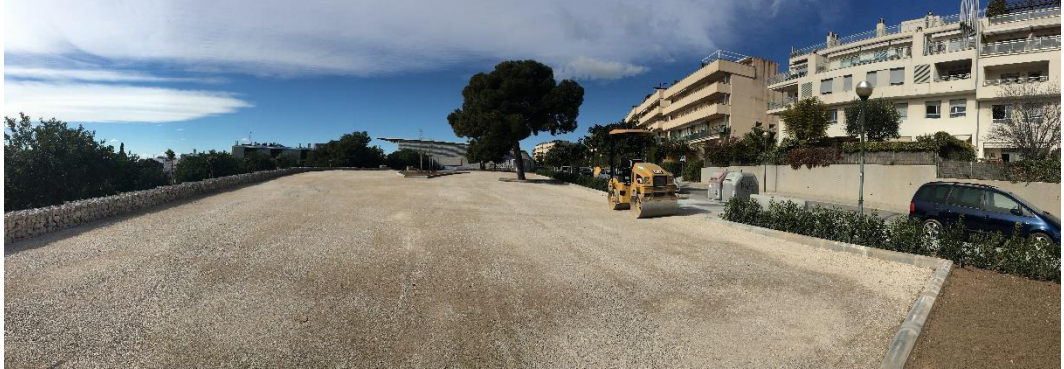
Figura 8. Vista de la zona d'aparcament actual (nord de l'àmbit)
