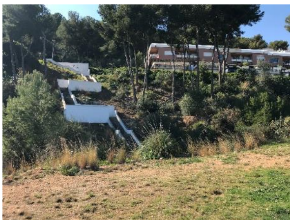
Escales existents que comuniquen carrer Marqués de Comillas.
